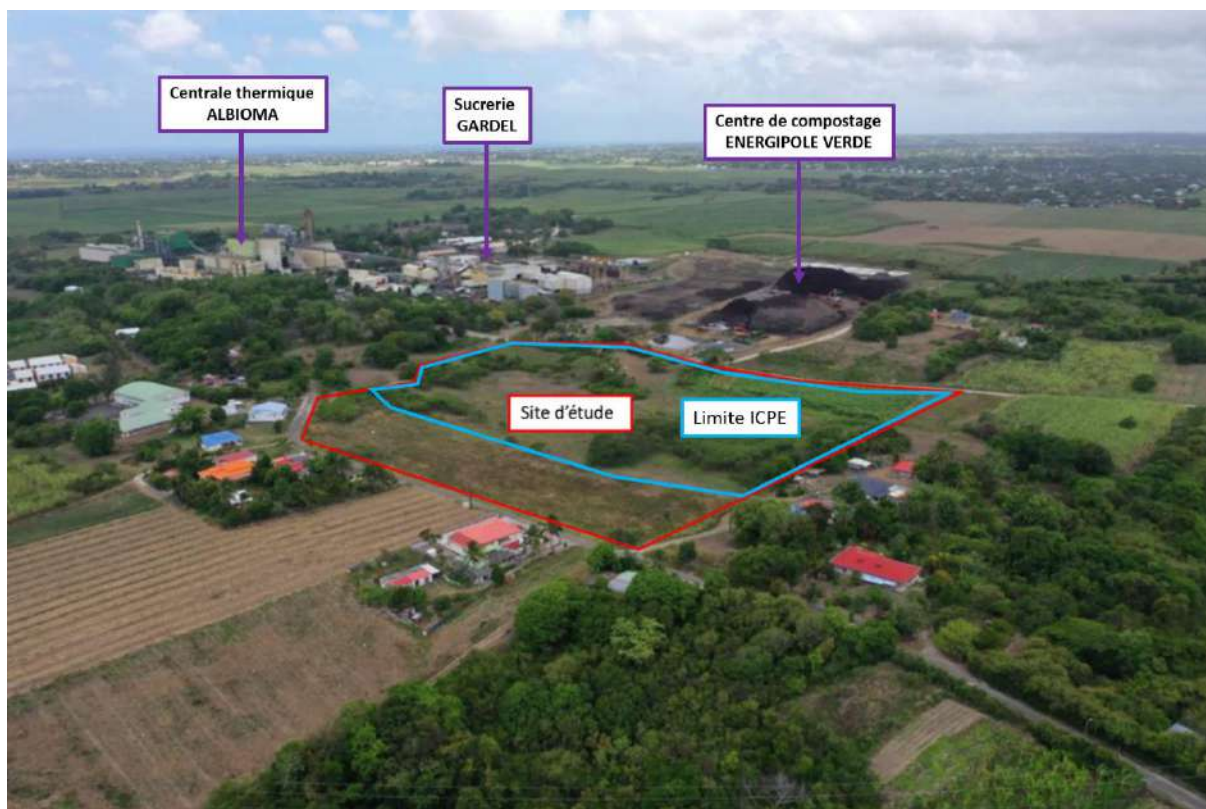
Figure 34 : Vue de Sud-Ouest du site (source : BIOS, 2020)
